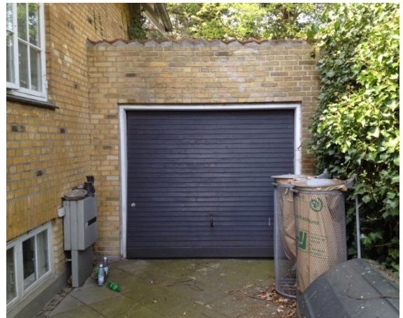
| Den nye port bør holdes i samme stil som den oprindelige.
