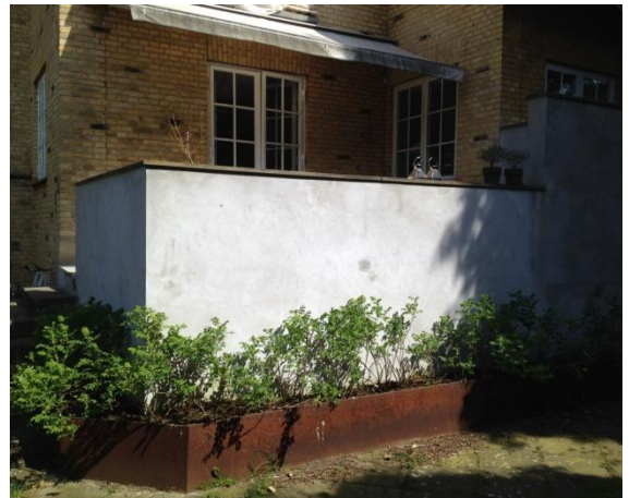
Terrassen set udefra. Siderne skal der ikke røres ved, andet end afdækningerne måske.
