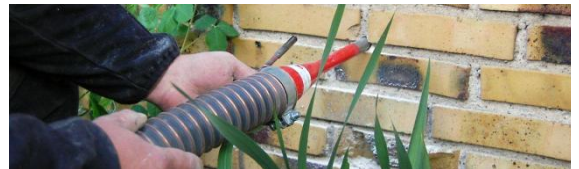
I dag borer man typisk et stort hul i fugerne, og blæser granulat ind.
